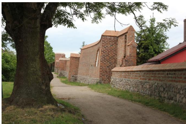
Zachowane mury obronne
