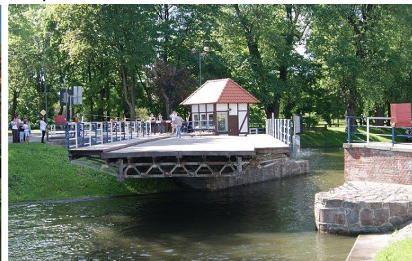
Most obrotowy nad Kanałem Łuczańskim
